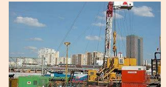
Forage pour alimenter un réseau de chaleur urbain de la CPCU à la porte d'Aubervilliers, Paris, 2009. © BRGM
