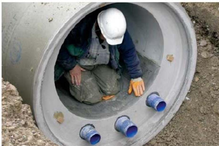
Illustration 91 : Illustration de canalisation avec capteurs préfabriqués (source [43])
